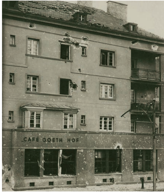
Im Goethe-Hof in Donaustadt sammelten sich im Februar 1934 Schutzbündler - der Gemeindebau wurde von Regierungstruppen mit Haubitzen, Kanonen und Maschinengewehren beschossen.
