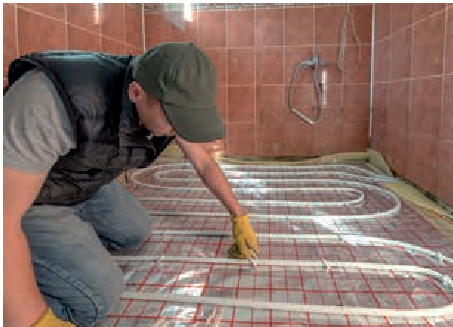
Wohlig. Fußbodenheizungen sind Flächenheizungen, die mit niedriger Temperatur betrieben werden.
